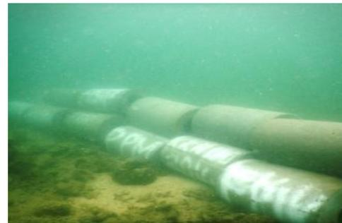
Gambar 8. Proses peletakan terumbu buatan di perairan
