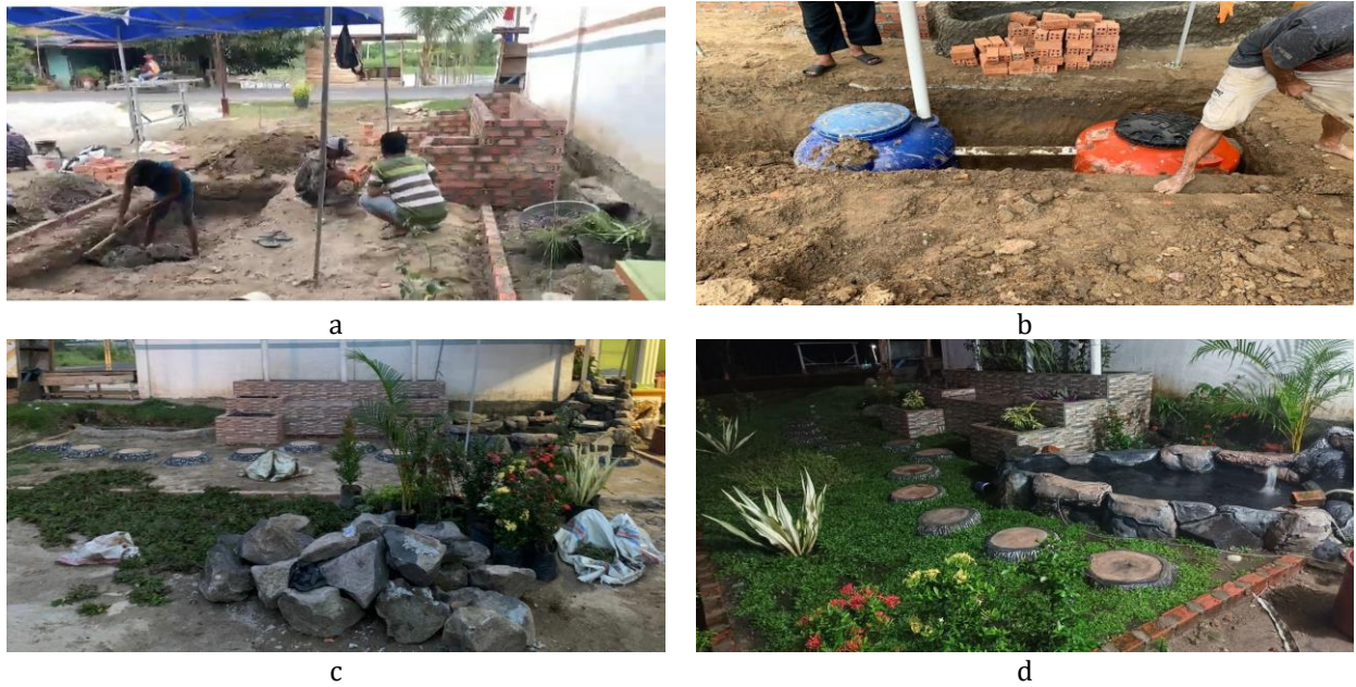
Gambar 4 a) Pemasangan bangku taman dan penggalian sumur resapan dan bioswale , b) Pemasangan tedmon untuk sumur resapan dan ground water tank , c) Pesiapan untuk penanaman elemen softscape , dan d) Penampakan taman ketika malam hari
