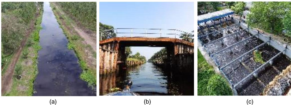
Gambar 2 Kanal utama, tanggul yang terbuat dari bahan organik, dan pintu air utama di daerah pesisir Pulau Burung Riau (Tay Juhana Foundation 2021).
